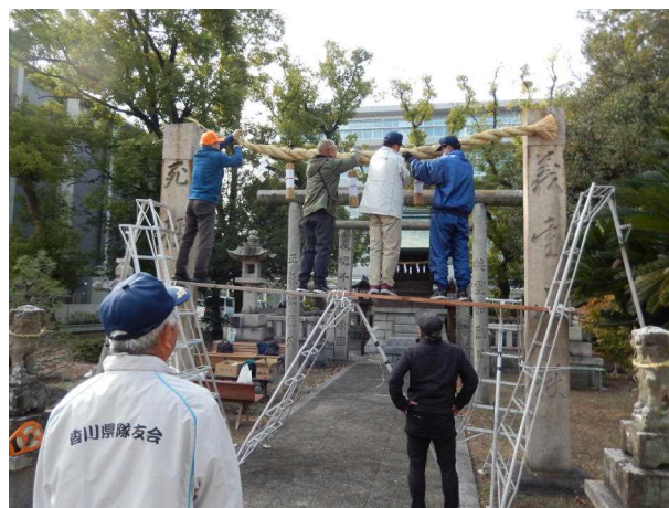
大注連縄の石柱吊り下げ
